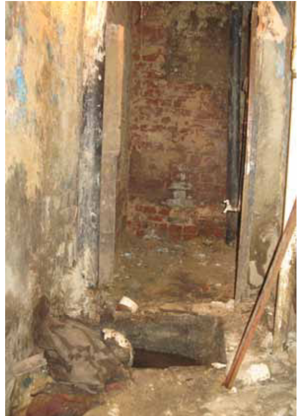
البيوت قبل ترميمها © مني زكريا للاستشارات الهندسية
